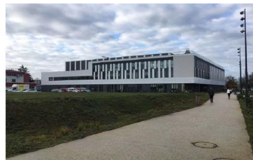
Bâtiment ICE (D128)
